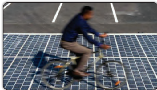
Görsel 2.15 Güneş Paneli İle Çalışan Yol
